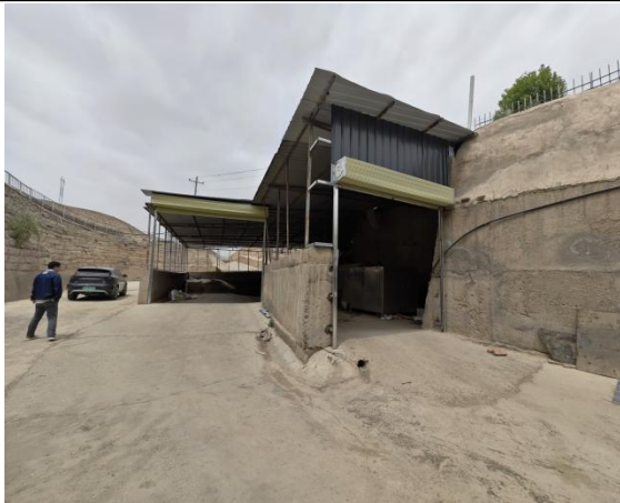
沼渣临时堆场和病死猪无害化处理间
