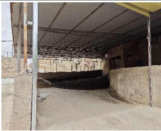
沼渣临时堆场
