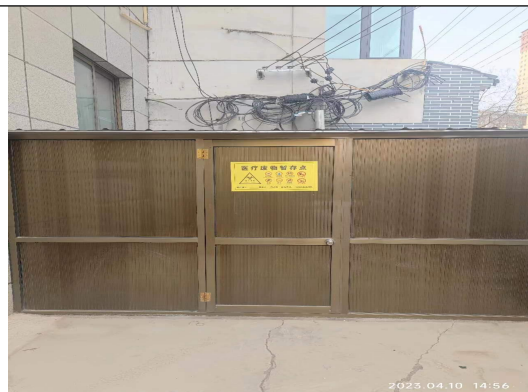
医疗废物暂存间
