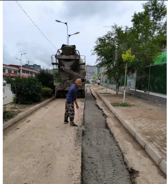
施工期道路恢复
