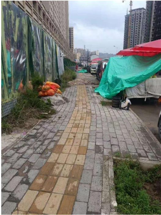
已恢复路面支线（沿人行道铺设）
