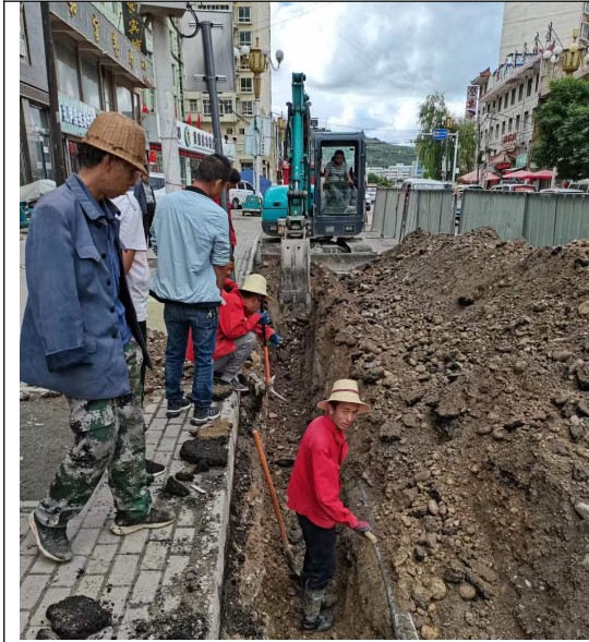
施工期开挖路段
