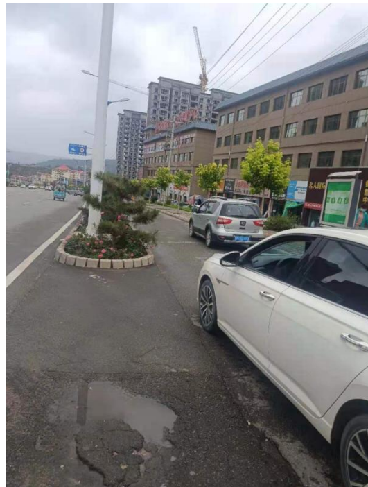
已恢复路面支线 (沿非机动车道铺设)
