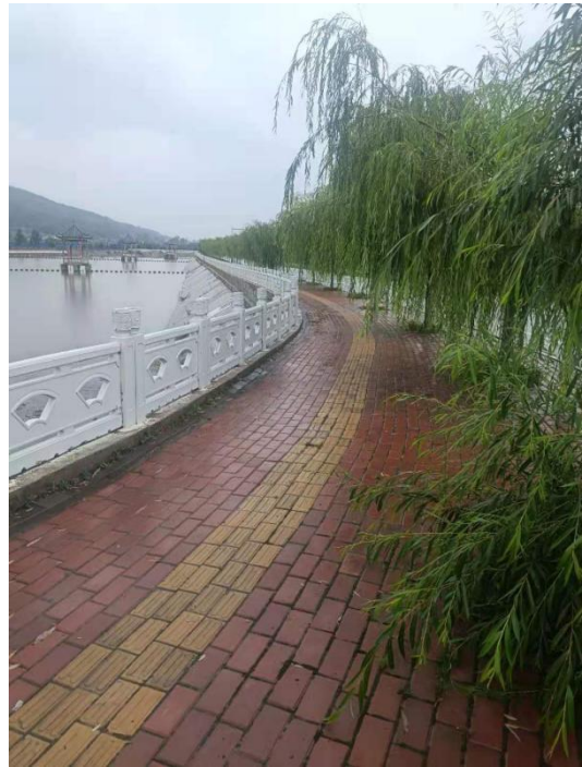
主管线（沿人行道铺设）
