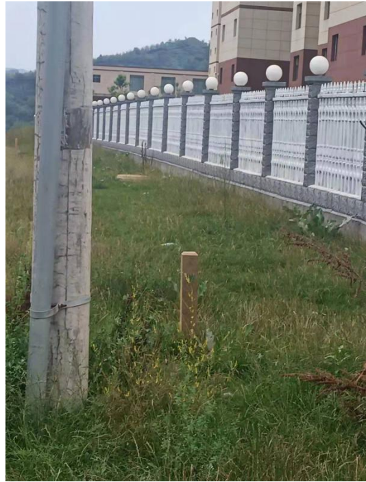
已恢复路面支线（沿河道边草坪铺设后入小区）
