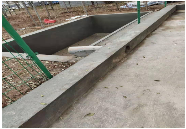
事故应急池及围堰
